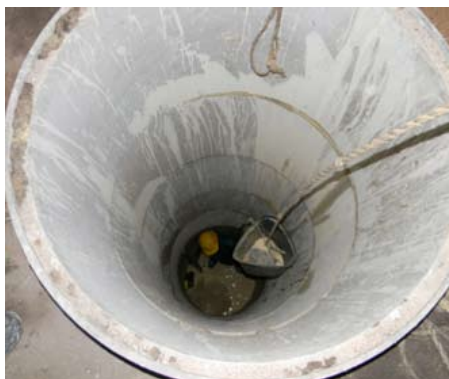
Para trabajar dentro de las reducidas dimensiones del pozo hay que sacar la tierra cubo a cubo hasta que finalmente brota el agua.
