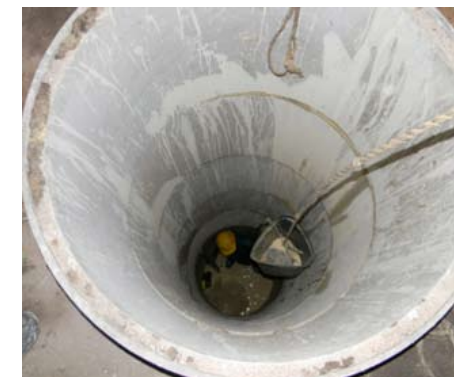
Para trabajar dentro de las reducidas dimensiones del pozo hay que sacar la tierra cubo a cubo hasta que finalmente brota el agua.
