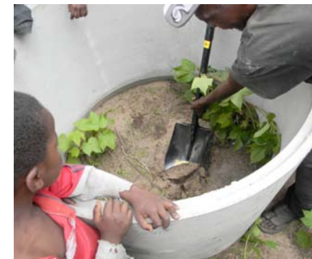
El jefe local empieza el proceso de excavación sacando la primera paletada de tierra.
